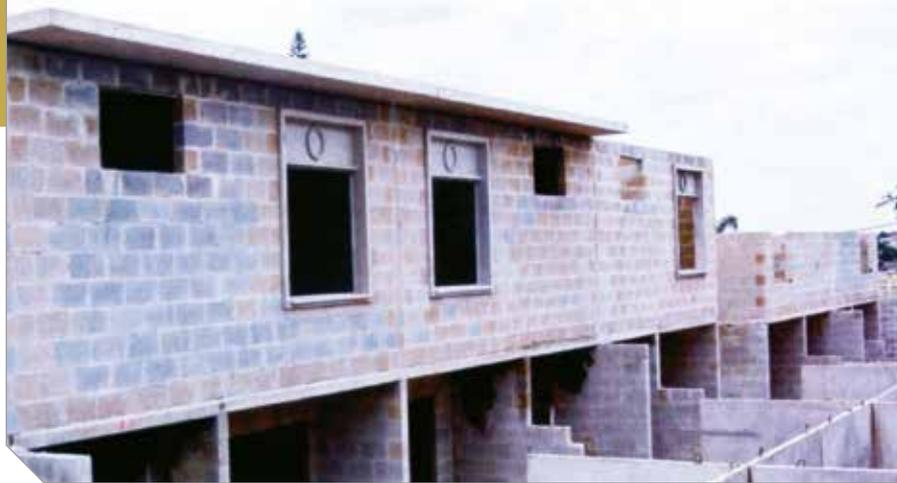
**Construção dos sobrados do Villagio Maia, com blocos de concreto produzidos com RCD (Capello, 2006)**
